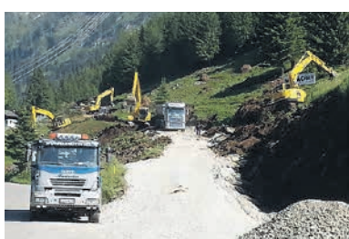
An der Ersatzstraße über den Felbertauern wird fiebrig gearbeitet.
